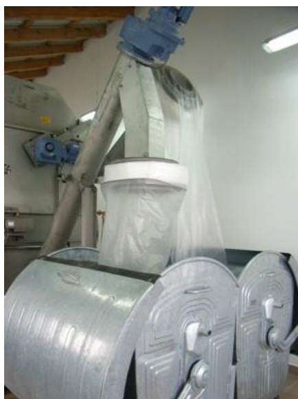
Slika 2.4. Izbacivanje izdvojenog pijeska iz kompaktnog uređaja za predtretman
