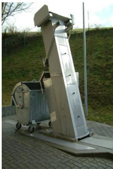
Slika 2.1. Automatska gruba rešetka
