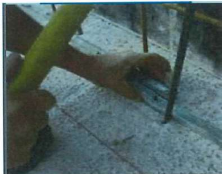
Hidrofilna bubreća bentonitna traka za brtvljenje
